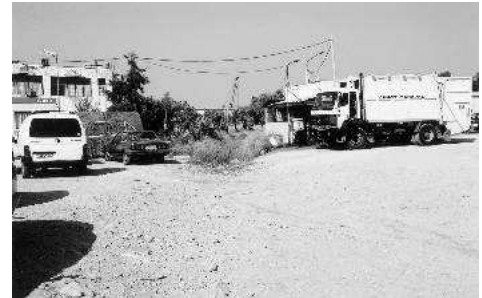
Στο βάθος, ανάμεσα στο ΙΧ και τα φορτηγά του δήμου, διακρίνουμε το ρέμα Σούρες να ...διασχίζει το εργοτάξιο
